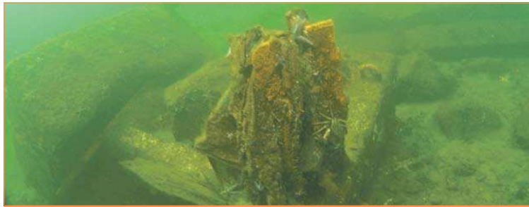
Reste eines Hafensteiges mit Eisenträgern.
